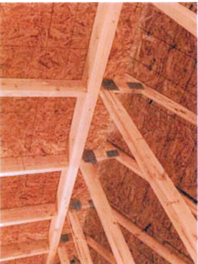
Energy Heel Truss
